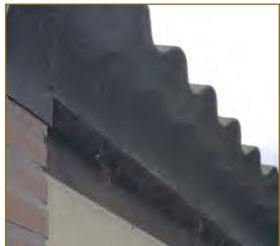
Afbeelding 2.6: Dakoverstek van beide schuren hebben openingen tussen dakbedekking en gevel. Dit is voorzien van vogelschroot.
