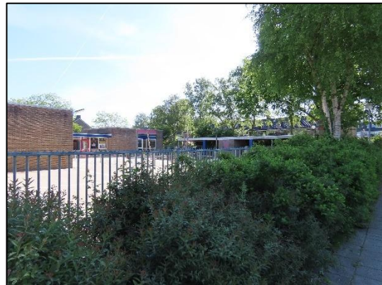
Fig. 2.4, Schoolgebouw (zuidzijde) (bron: FF Solutions)
