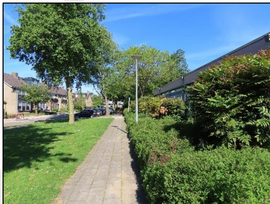
Fig. 2.5, Schoolgebouw (zuidzijde) (bron: FF Solutions)
