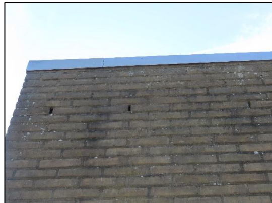
Fig. 2.6, Open stootvoegen in schoolgebouw (bron: FF Solutions)
