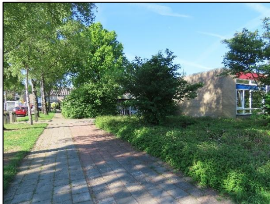
Fig. 2.3, Schoolgebouw (oostzijde) (bron: FF Solutions)
