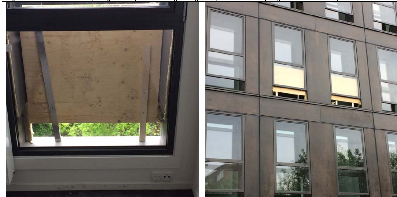
Figuur 3: Harbour Fenster – opening buitenzijde 50% dichtgezetafgedicht, extra randabsorptie gehandhaafd (rechts)
