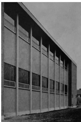
De gevels van de gymzaalvleugel zijn in de loop der tijd nauwelijks gewijzigd. Kozijnen en ramen zijn origineel. Ze zijn slechts voorzien van rolluiken. Op de noordgevel is in de loop der tijd een klimmuur aangebracht (Bouwkundig Weekblad 1957).
