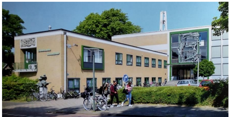
Ook in de bestuursvleugel zijn de tuimelramen vervangen door schuiframen. Een uitzondering vormen de pui met raam en deur bij het balkon en het grote venster van de voormalige rectorkamer. Deze hebben nog hun oorspronkelijke houten uitvoering. Op de kopgevel staat met groene letters 'Groen van Prinsterer' (Kegel 2019).
