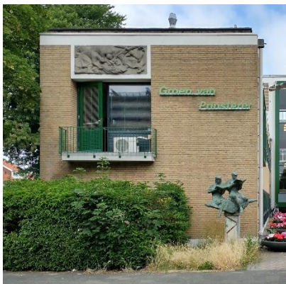
Ook in de bestuursvleugel zijn de tuimelramen vervangen door schuiframen. Een uitzondering vormen de pui met raam en deur bij het balkon en het grote venster van de voormalige rectorkamer. Deze hebben nog hun oorspronkelijke houten uitvoering. Op de kopgevel staat met groene letters 'Groen van Prinsterer' (Kegel 2019).
