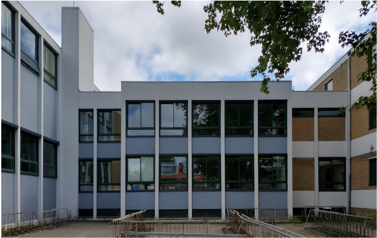
De invulling van de westgevel van de practicumvleugel is vergelijkbaar met die van de zuidgevel van het hoofdvolume: vensters ter plaatse van leslokalen en metselwerkvlakken ter plaatse van facilitaire ruimten. Op de overgang tussen dit bouwdeel en de gymzaalvleugel vormt een betonnen schoorsteen een verticaal element.
