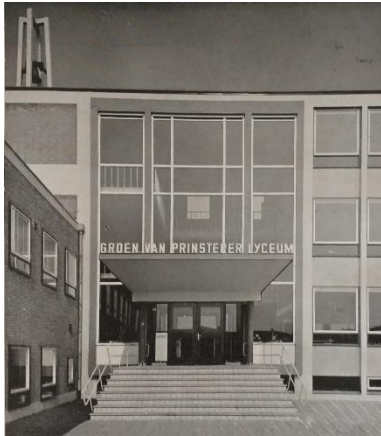
Aanzicht van de entree in (van links naar rechts) 1957, 2007 en 2022. Oorspronkelijk stond de naam van de school in hoofdletters op de luifel. De kozijnen van de entreepui zijn origineel, maar hebben niet meer hun oorspronkelijke kleur. De toegangsdeuren zijn in de loop der tijd meermaals aangepast. In 2007 is boven de luifel een kunstwerk geplaatst (Bouwkundig Weekblad 1957, Beeldbank Rijksdienst voor het Cultureel Erfgoed, 523.696).
