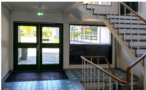
Trappenhuis (links) en doorbraak richting de kantine, vanuit de practicumvleugel gezien. De vierkante betonkolommen bovenaan de trap zijn de oorspronkelijke gevelkolommen.
