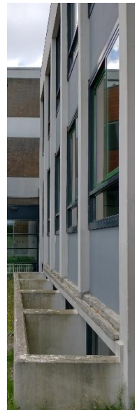
In de oostgevel van de practicumvleugel bevindt zich een trappenhuis met een twee verdiepingen hoge pui. Boven de nooduitgang onderin het trappenhuis hangt een eenvoudige, betonnen luifel. Betonnen bakken voor de gevel (rechts) herinneren aan de oorspronkelijke functie van het souterrain: kolenhok.
