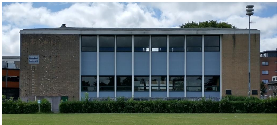
De gevels van de gymzaalvleugel zijn in de loop der tijd nauwelijks gewijzigd. Kozijnen en ramen zijn origineel. Ze zijn slechts voorzien van rolluiken. Op de noordgevel is in de loop der tijd een klimmuur aangebracht (Bouwkundig Weekblad 1957).
