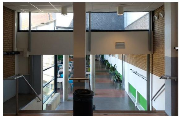
Trappenhuis (links) en doorbraak richting de kantine, vanuit de practicumvleugel gezien. De vierkante betonkolommen bovenaan de trap zijn de oorspronkelijke gevelkolommen.
