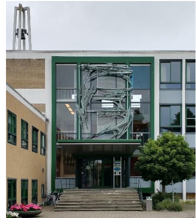
Aanzicht van de entree in (van links naar rechts) 1957, 2007 en 2022. Oorspronkelijk stond de naam van de school in hoofdletters op de luifel. De kozijnen van de entreepui zijn origineel, maar hebben niet meer hun oorspronkelijke kleur. De toegangsdeuren zijn in de loop der tijd meermaals aangepast. In 2007 is boven de luifel een kunstwerk geplaatst (Bouwkundig Weekblad 1957, Beeldbank Rijksdienst voor het Cultureel Erfgoed, 523.696).
