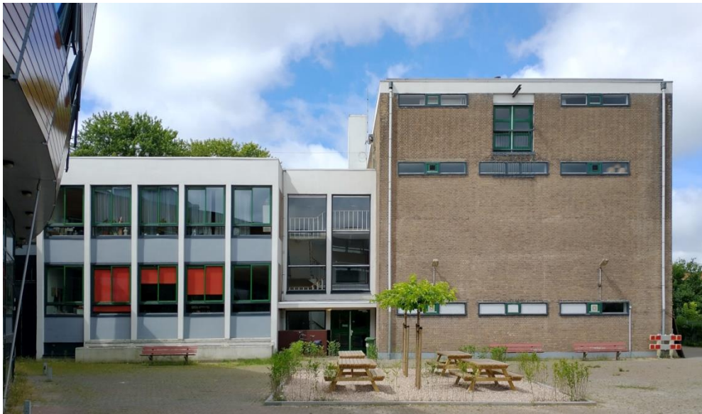
In de oostgevel van de practicumvleugel bevindt zich een trappenhuis met een twee verdiepingen hoge pui. Boven de nooduitgang onderin het trappenhuis hangt een eenvoudige, betonnen luifel. Betonnen bakken voor de gevel (rechts) herinneren aan de oorspronkelijke functie van het souterrain: kolenhok.
