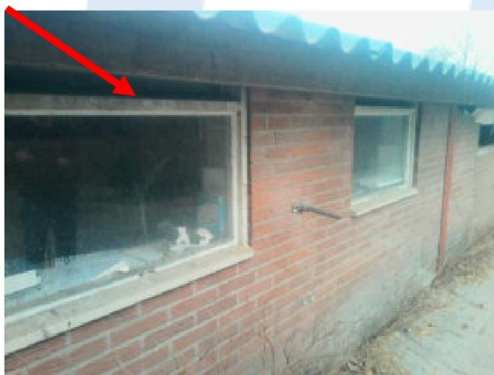
Foto 20 | Ventilatieklepjes kozijn tanklokaal
