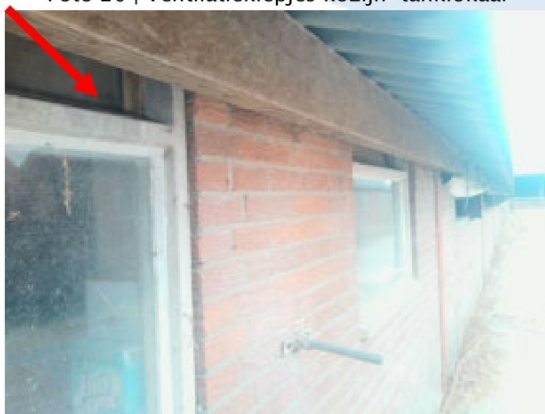
Foto 22 | Ventilatieklepjes kozijn tanklokaal
