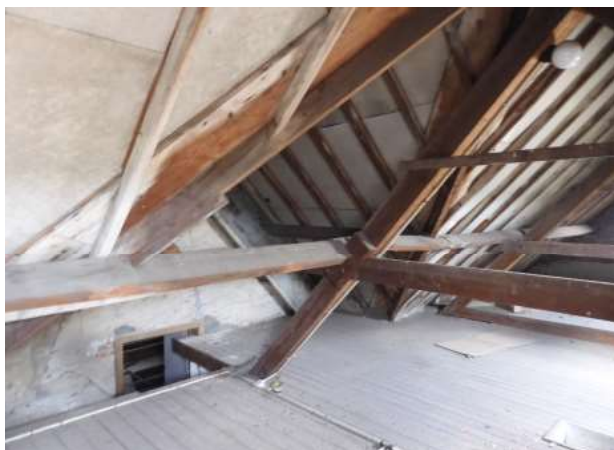
De hoekkeper, gevormd door de dakvlakken van de volumes A en C.
