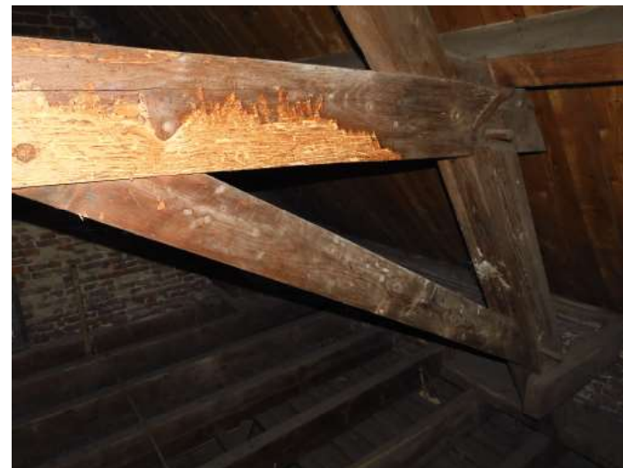
De horizontale dekbalk is met een houten pen aan het spantbeen verankerd. Tussen gording en dekbalk is een koppelijzer te zien. De diagonale balk tussen het spantbeen en de onderkant van de dekbalk is de korbeel.
