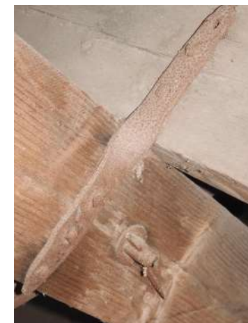
Aan de ene kant van de balken een ijzeren spie die aan de andere kant met een grote ronde kop is gezekeerd.
