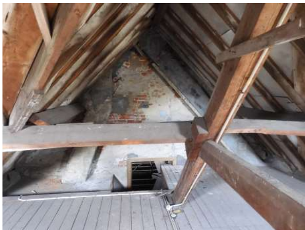
Dit deel van de kap is via een tussenmuur verbonden met de kap van volume C.
