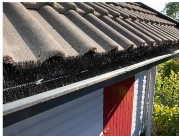
Figuur 8.6 Voorbeeld van toepassen spouwborstels in dakgoot.
