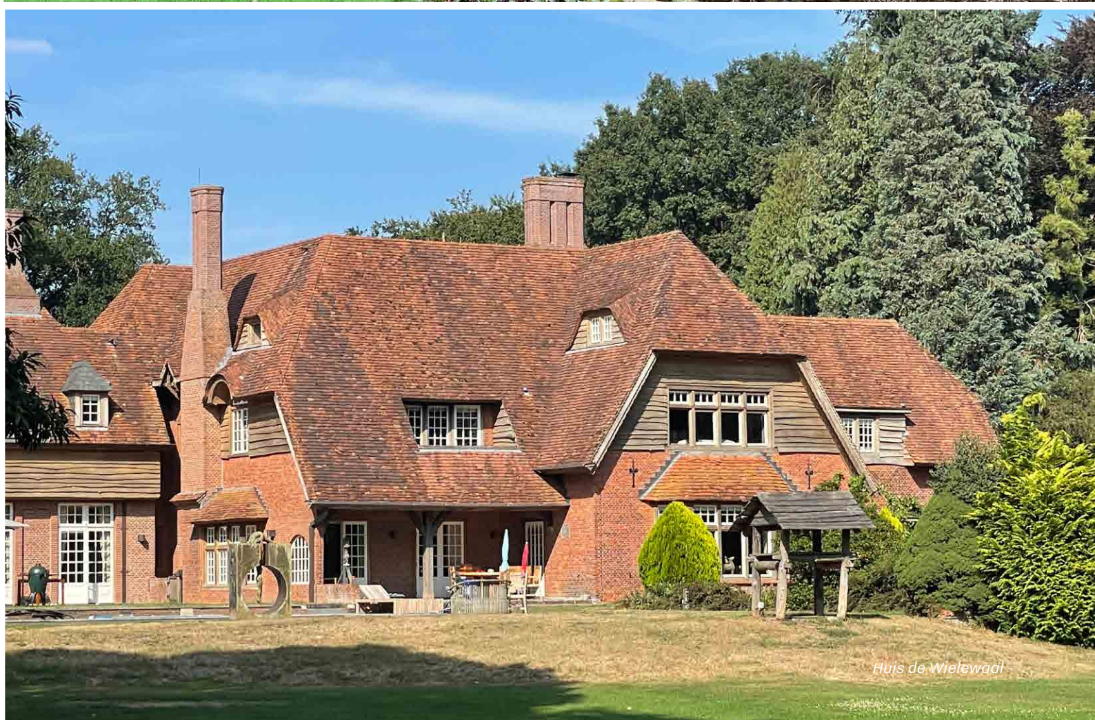
De Wielewaal, zuidgevel
