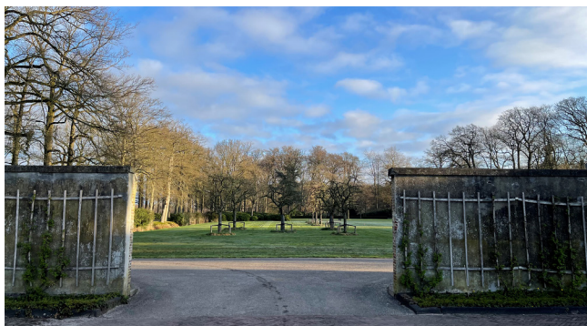
2020 - Een asfaltweg en opening in de tuinmuur.
