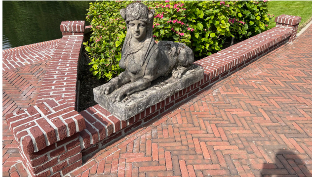
Bestaande gemetselde muurtjes en trap bij Grote vijver.
