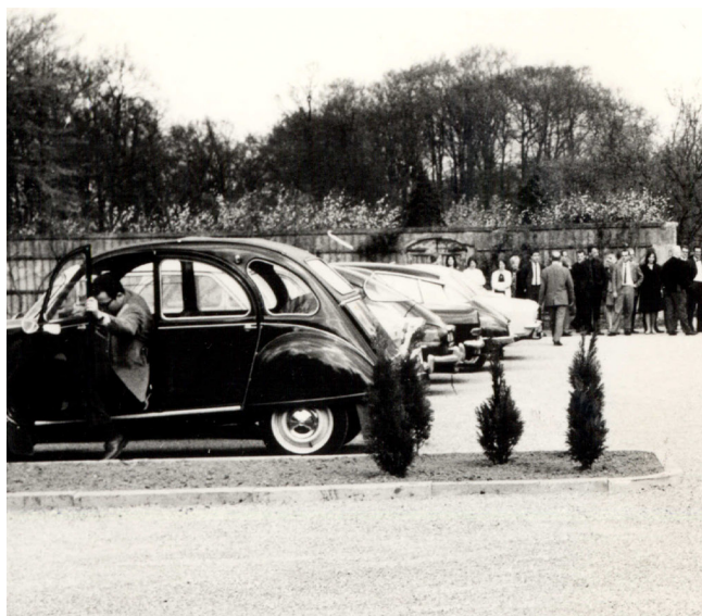
ca. 1963 - De aangelegde parkeerplaats in de ommuurde moestuin. (HA nr. 970113)
