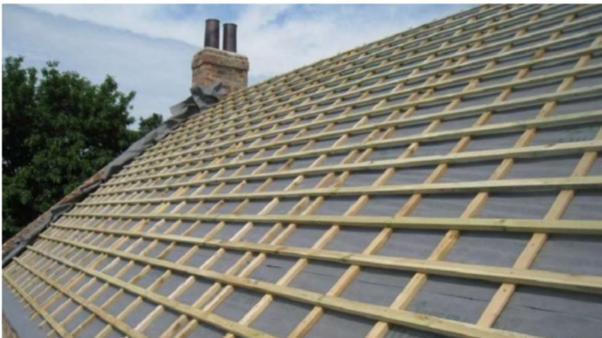
Dak met BAT Safe (vleermuisvriendelijke dampopenfolie) (Bron: Unitura.nl)
