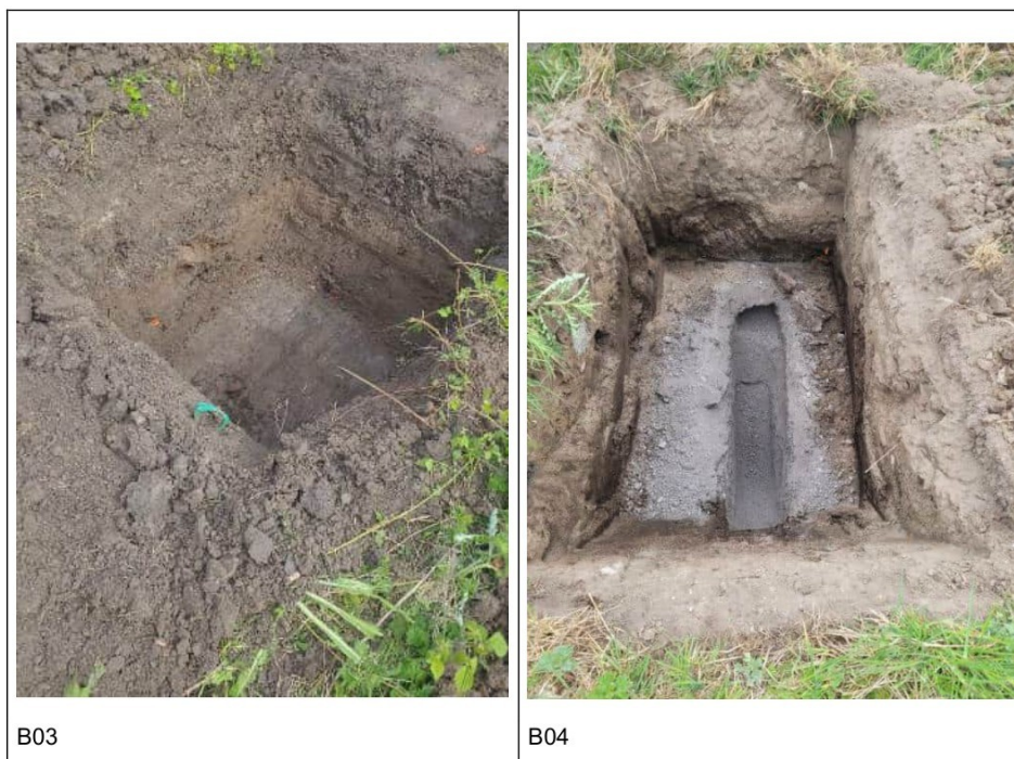
Figuur 2-1 Foto's inspectiegaten staalslakken
