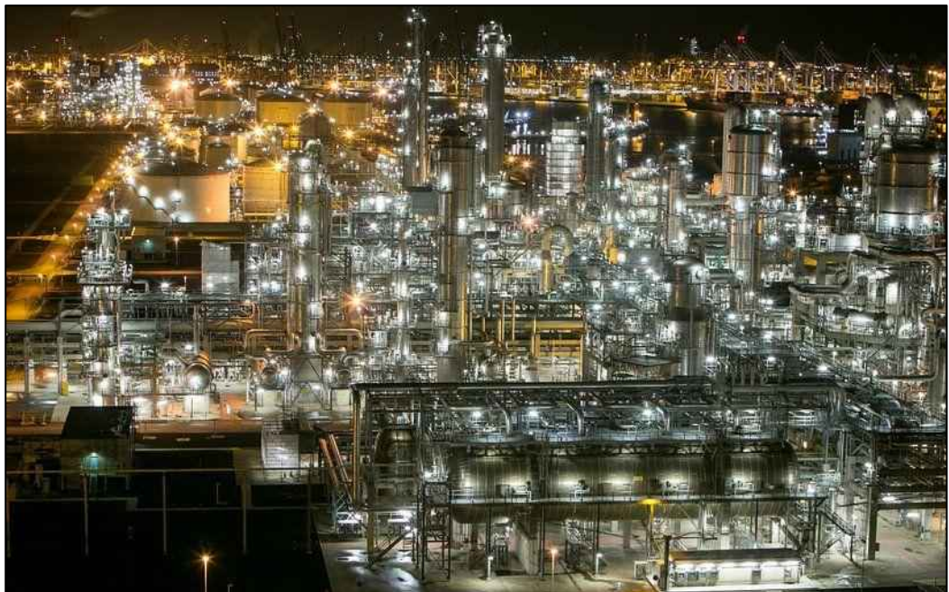
Figuur 3. Zicht op een deel van de Europort bij nacht. De hoeveelheid kunstlicht is overweldigend waardoor het complex volledig ongeschikt is voor vleermuizen.
