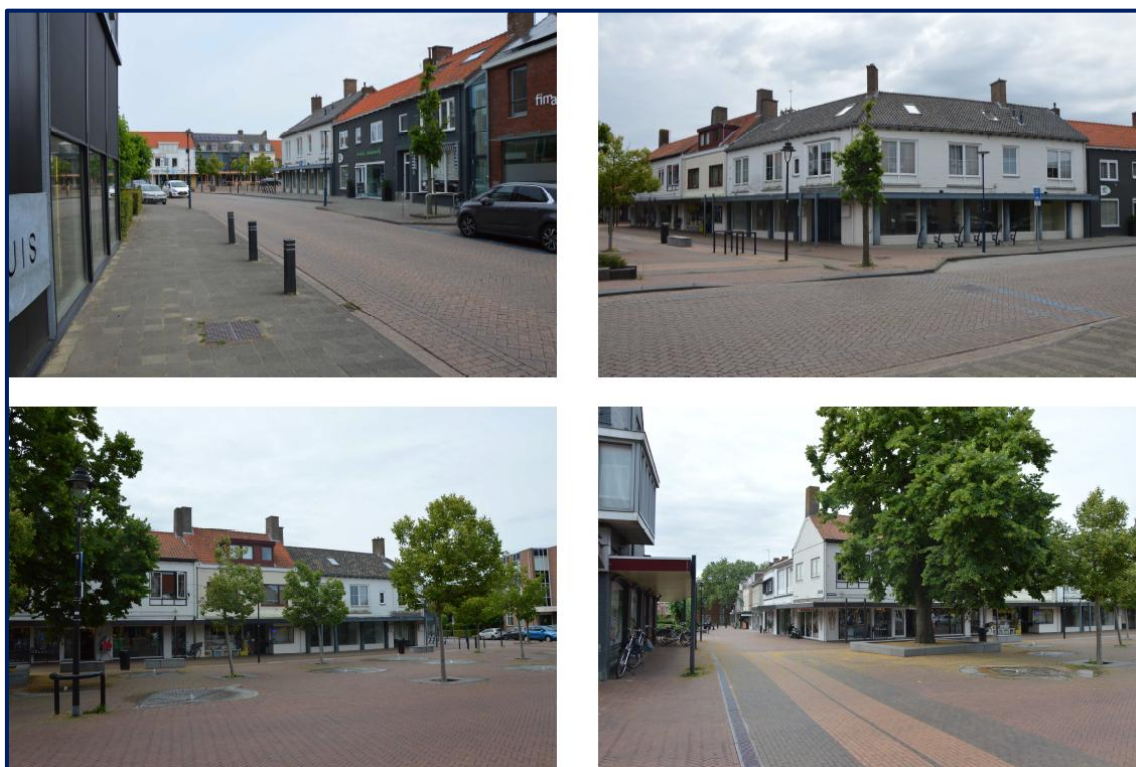
FIGUUR 2.1: FOTO'S HUIDIGE SITUATIE (BRON: VG ARCHITECTEN)
