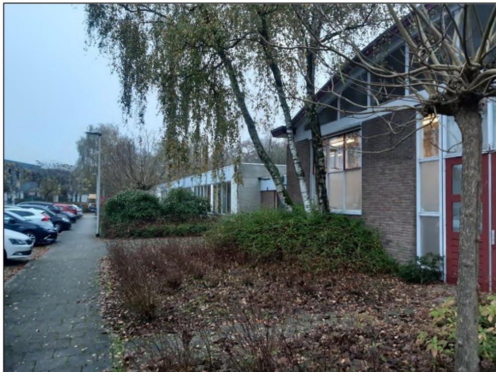
Foto 2. Noordzijde van het UBC-gebouw. Gefotografeerd richting het oosten.
