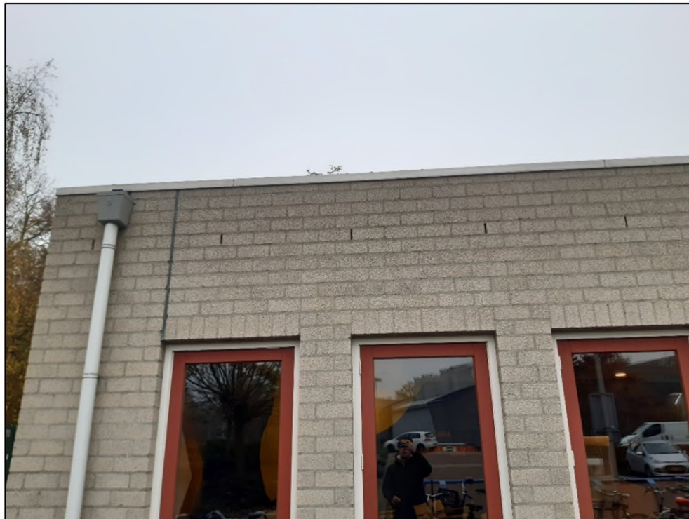
Foto 7. Open stootvoegen bieden toegang tot de spouwmuur.
