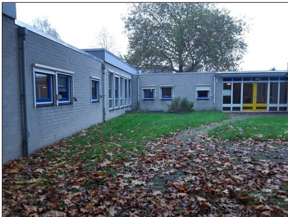
Foto 6. Speelplaats en zuidoostgevel van de Gele Vlieger. Gefotografeerd richting het noorden.
