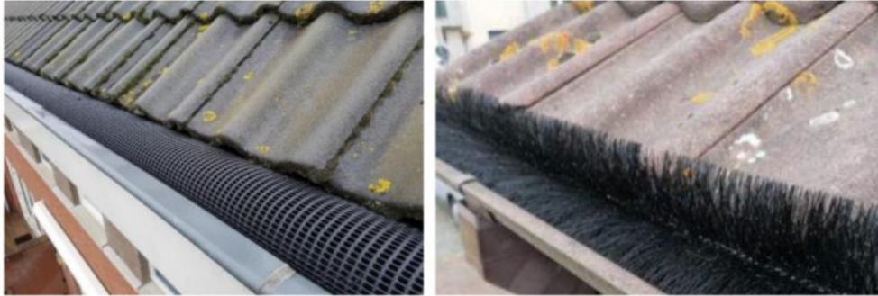
Afbeelding 10: Gootrollen of gootborstels, voorkomt dat huismussen onder de eerste rij van de dakpannen broeden.
