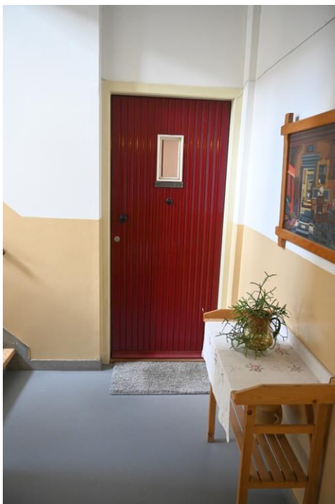
◄▲ Trappenhuis voor de bovenwoningen is voorzien van diverse afwerkingen en details uit de bouwtijd zoals voordeuren, traptegels, handleuningen en hekwerk voor de vensters. De wanden van het trappenhuis zijn conform bestek afgewerkt met betonemaille. Foto's J. Krijnen - gemeente Zutphen 2024
