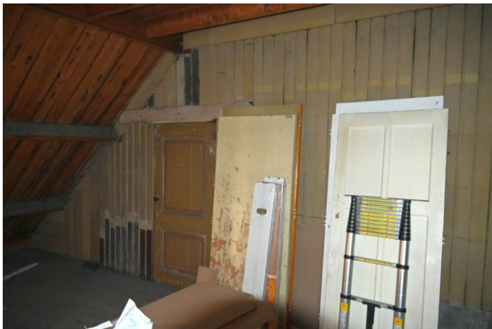
◀ Op zolder zijn tijdens de bouw materialen uit gesloopte panden hergebruikt. Foto J. Krijnen - gemeente Zutphen 2024
