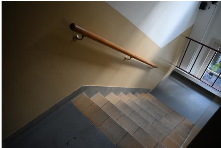
◄▲ Trappenhuis voor de bovenwoningen is voorzien van diverse afwerkingen en details uit de bouwtijd zoals voordeuren, traptegels, handleuningen en hekwerk voor de vensters. De wanden van het trappenhuis zijn conform bestek afgewerkt met betonemaille. Foto's J. Krijnen - gemeente Zutphen 2024
