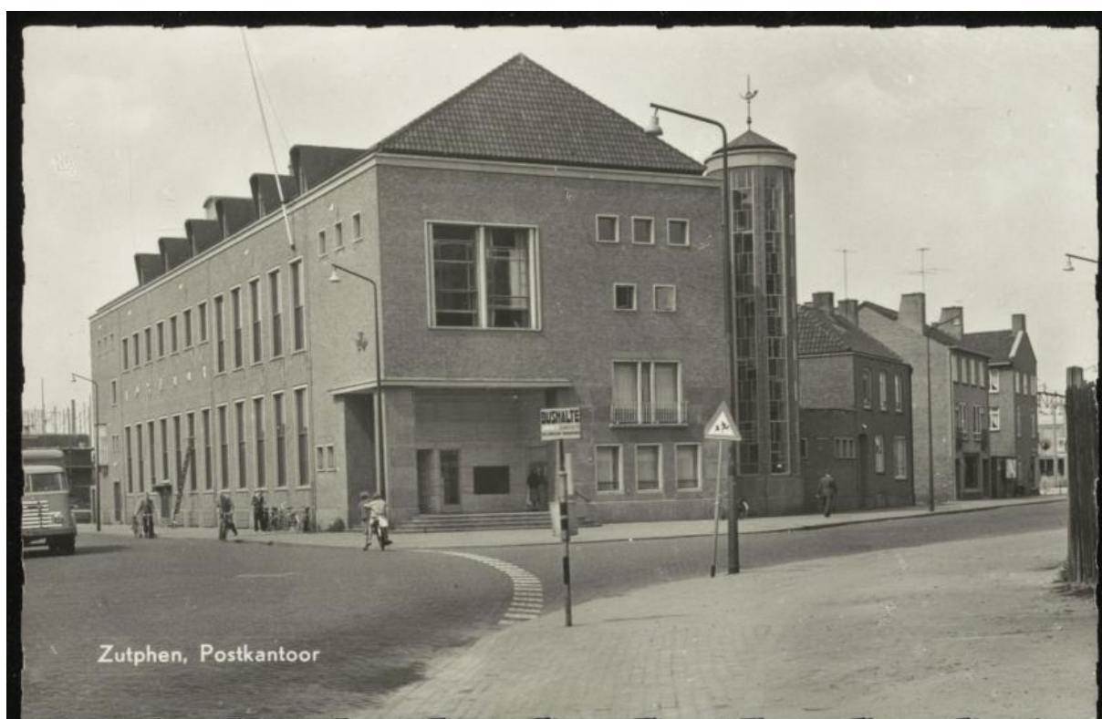
▲ Het postkantoor kort na oplevering in 1954. Bron: Erfgoedcentrum Zutphen
