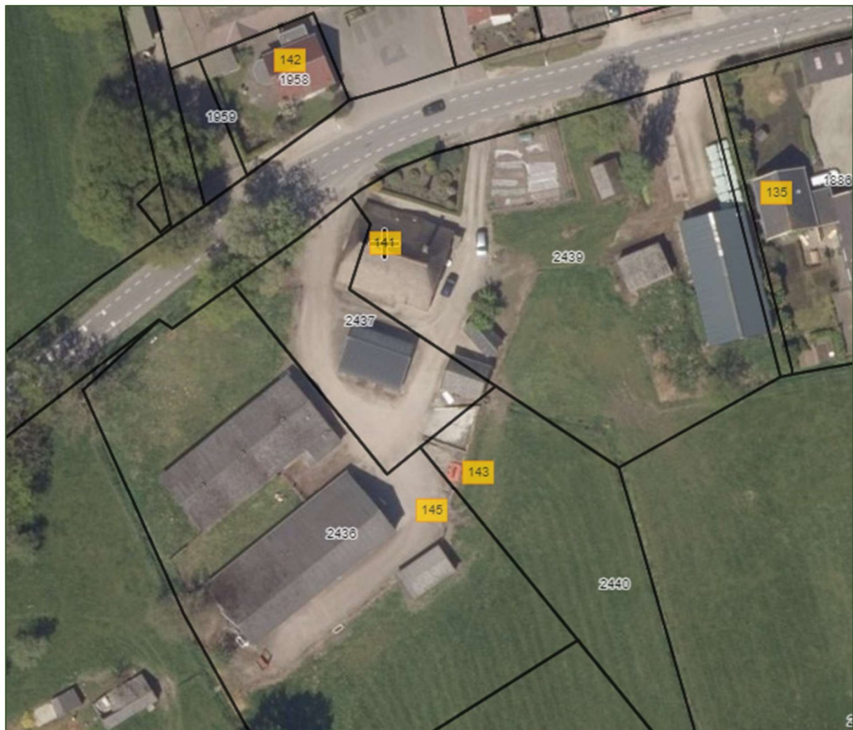
Figuur 5: luchtfoto Garderenseweg 141, feitelijk gerealiseerde situatie (bron: StreetSmart)
