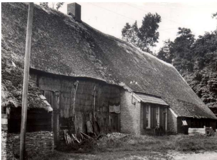
4. In 1959 bestonden de wanden van het verlengde van de boerderij uit strowanden.
