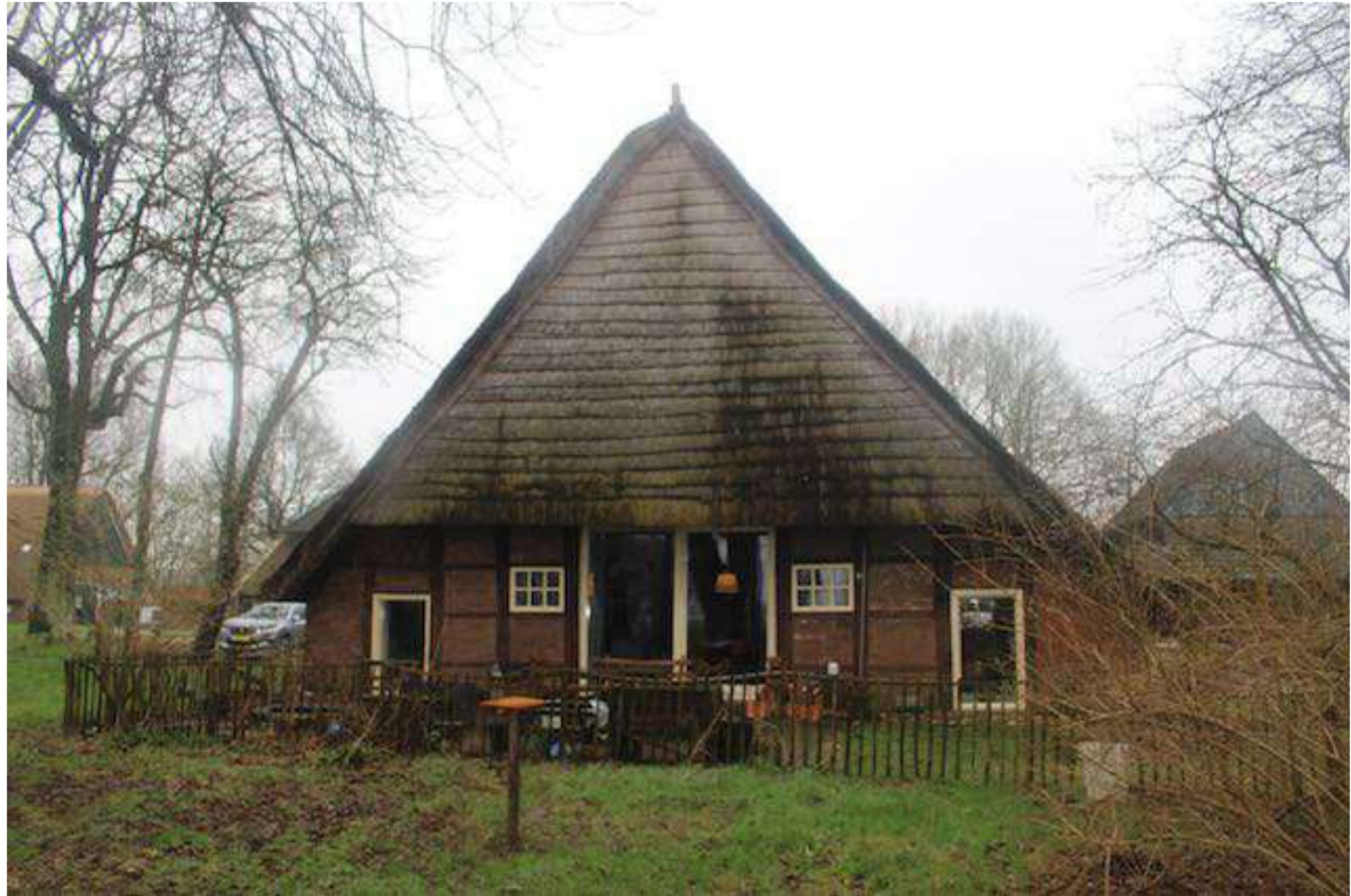
2. De noordgevel. De bakstenen hebben een formaat van 21,5 x 9 x 4 cm, een tienlagenmaat van 56,5-57 cm. In de bovenste vakken zijn de stenen 5 cm dik. De vakken uiterst links en rechts zijn gevuld met vlechtwerk van stro.
