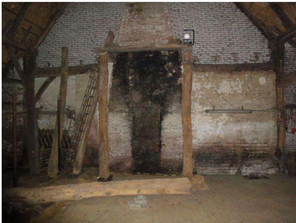
71. In de schuur (het andere deel van het complex, oorspronkelijk ook een boerderij met woondeel) is de schoorsteen van de schouw nog aanwezig.
