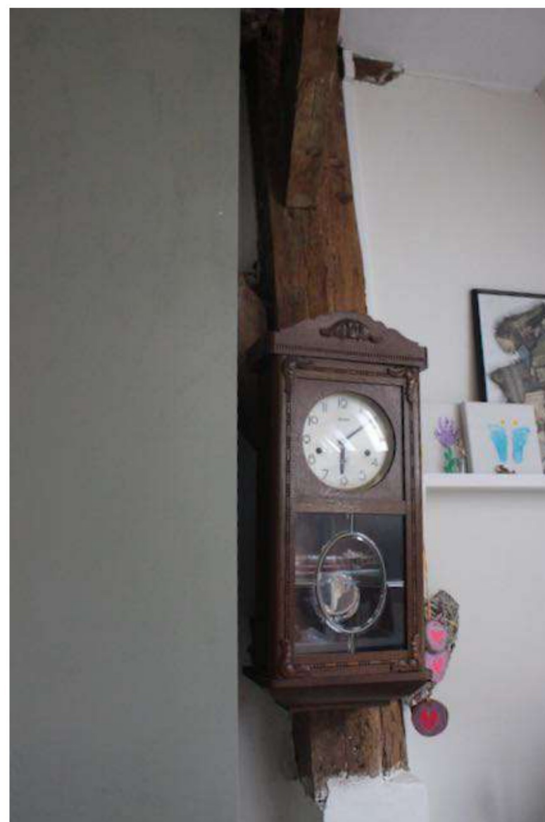
63. De vijfde stijl in de woonkamer staat voor de helft op een stenen voet.
