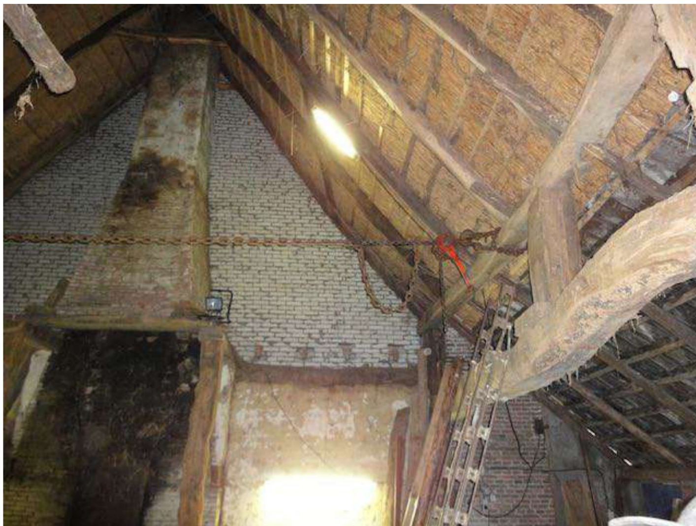
73. Ook in dit deel van het complex is een onderslagbalk aangebracht, wat erop wijst dat er oorspronkelijk een woonruimte is geweest. Daarop wijst ook de schoorsteen, waaronder een schouw is geweest.
