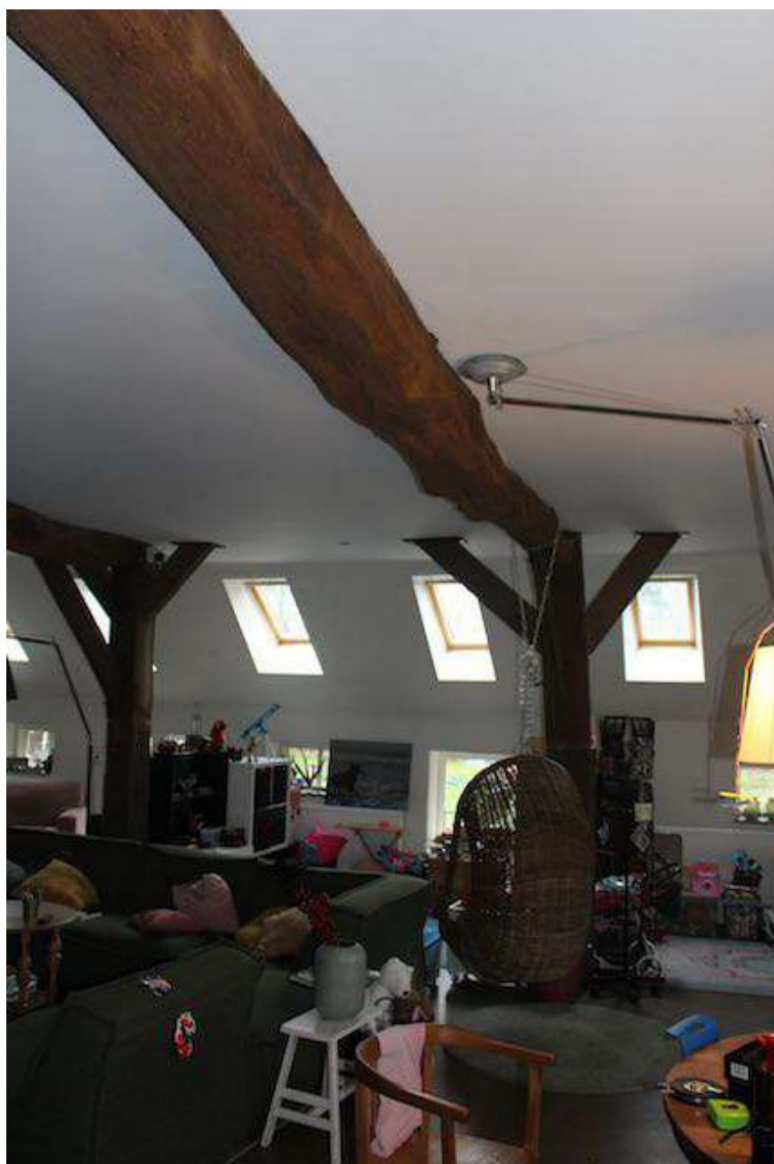
62. De ankerbalken domineren de visuele beleving van de woonkamer.
