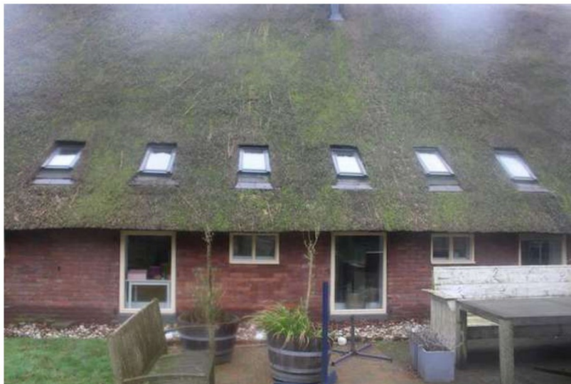
20. De betonnen stalvensters zijn gedeeltelijk vervangen door grote vensters. De bakstenen hebben een formaat van 21,5 x 10,3 x 5 cm, de tienlagenmaat bedraagt 70 cm. Ze zijn in halfsteensverband gemetseld met cementmortel.
