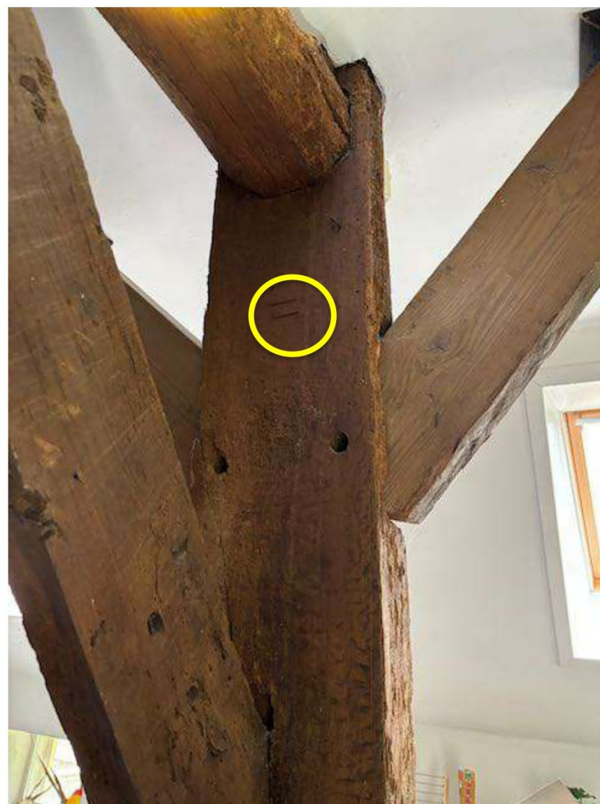
59. In de eerste zichtbare stijl staat het telmerk 2. Op één uitzondering na zijn verder geen telmerken aangetroffen.
