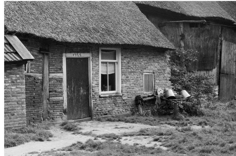
22-23. De vakwerkgevel westzijde. Op een foto uit 1962 staat op de bovendorpel boven de deur 1722. Het metselwerk ziet er in 1962 slecht uit. Rechts is een getralied venster te zien. Dat zat boven de kelder, die er toen nog was.
