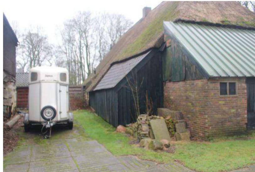
35b. De muur hield op waar de aanbouw begon. Het lijkt de bedoeling dat het nu beëindigde metselwerk doorgezet zou worden, omdat de baksteen daar een vertanding vormt. In de tussenmuur waarmee het voorste huis gescheiden is van het andere zit een balk van het geraamte.
