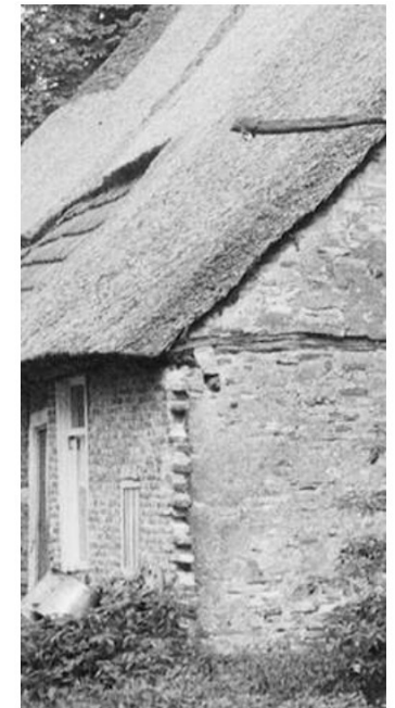
35b. De muur hield op waar de aanbouw begon. Het lijkt de bedoeling dat het nu beëindigde metselwerk doorgezet zou worden, omdat de baksteen daar een vertanding vormt. In de tussenmuur waarmee het voorste huis gescheiden is van het andere zit een balk van het geraamte.
