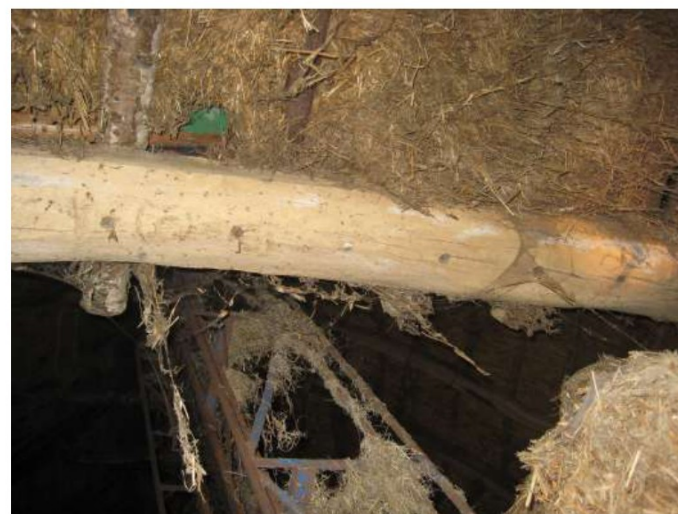
72. In een balk in de schuur zijn staakgaten te zien, wat erop duidt dat er een lemen wand is geweest.
