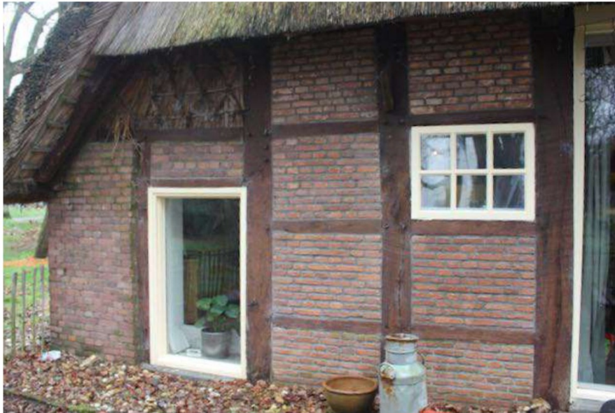
3-4. Vakwerk in de noordgevel. De baanderdeuren zijn vervangen door een schuifpui. De staldeuren door vensters.
