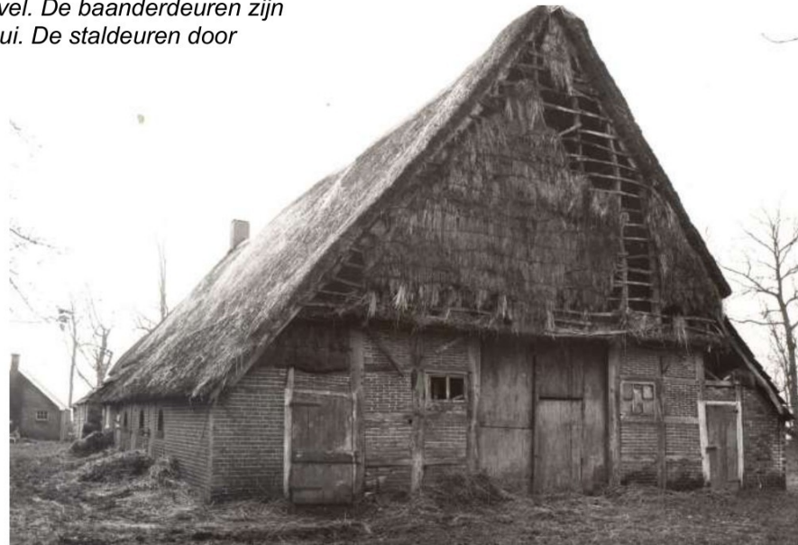
Op een foto uit 1972 is het verval van de boerderij goed te zien.
