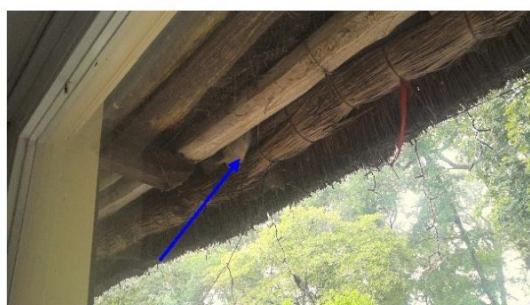
Originele dak opbouw
