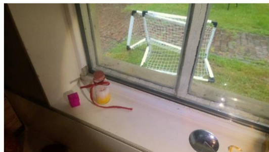
Enkel glas badkamer, niet asbestverdacht
