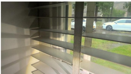
Dubbele beglazing in niet asbestverdachte kit gezet
