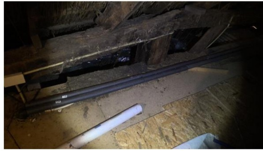
Leidingisolatie niet asbestverdacht
