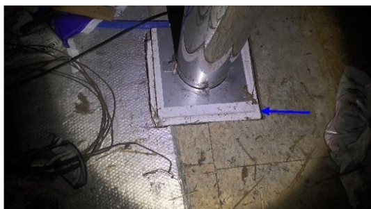
Brandwerende beplating niet asbestverdacht
