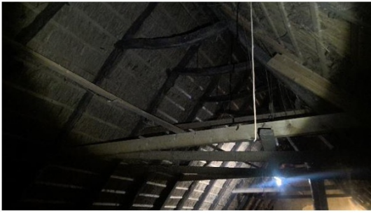
Houten balken met riet bedekt
