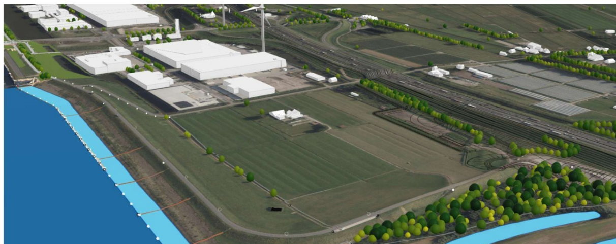
Figuur 7: kanaaldijk (zanddijk) en oude lekdijk (kleidijk)
