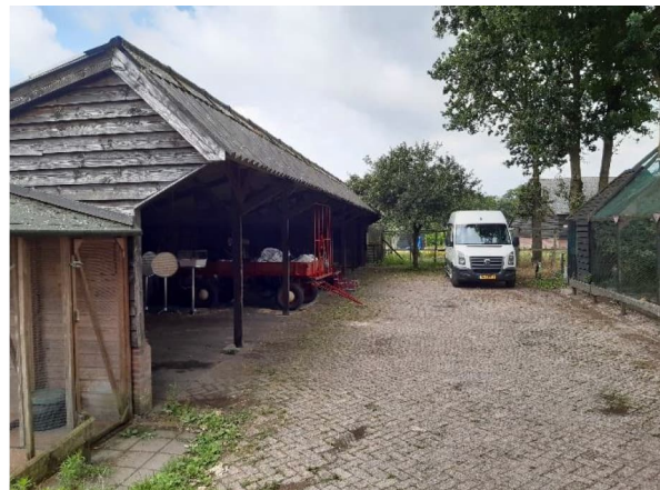
Foto 4: Aanwezige kleine loods op de onderzoekslocatie gezien in westelijke richting.
