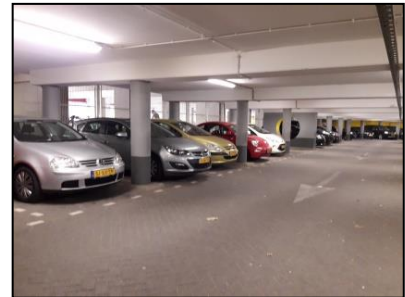
Figuur 11. Parkeergarage van het complex op de begane grond.
