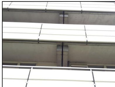
Figuur 13. Open dilatatievoegen.
