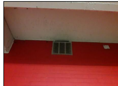
Figuur 14. Ventilatioerooster met spleet in parkeergarage van het complex.
