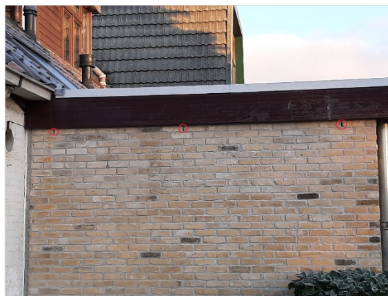
Figuur 5.4. Open stootvoegen in de aanbouw van Schulpweg 224, direct grenzend aan de te slopen bebouwing (rode cirkels).
