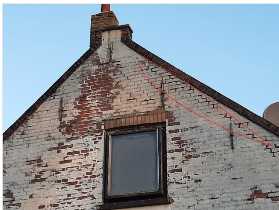
Figuur 5.3. Zuidelijke zijgevel van Schulpweg 226 met diverse spleten en openingen (rode omlijning).
