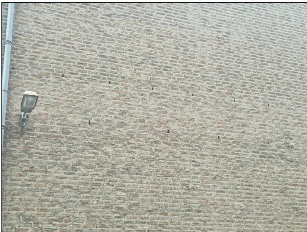
Figuur 3.1 Open stootvoegen in bebouwing.
