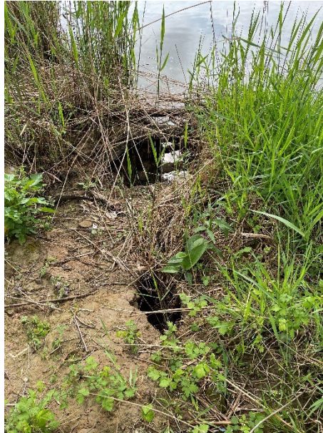
Deels ingestorte gang in de oever van de rivierarm ten westen van het inundatiekanaal.
