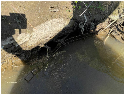
Locatie #3: Hopen afgezet met betongaas.
