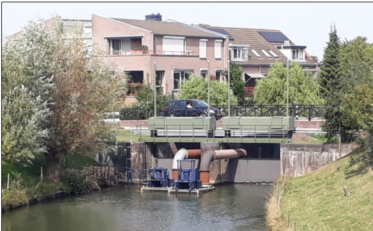
Figuur 25: Noodpompen bij inlaat Kromme Rijn
