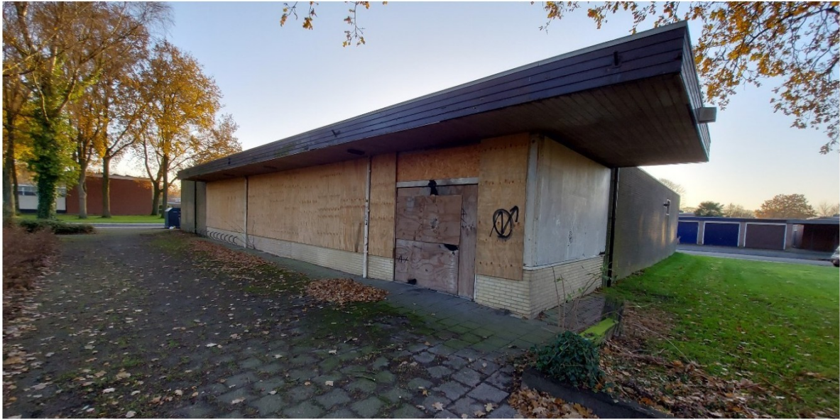
Voorzijde bebouwing (noordzijde), afgetimmerd met houten beplating.
