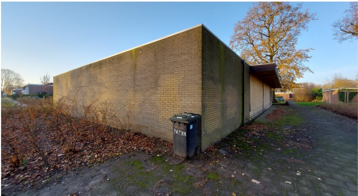
Oostelijke gevel (Veldlaan) en voorzijde (noord); openingen gedicht met houten platen, de open stootvoegen met bijenbekjes en de ventilatiegaten met purschuim.
