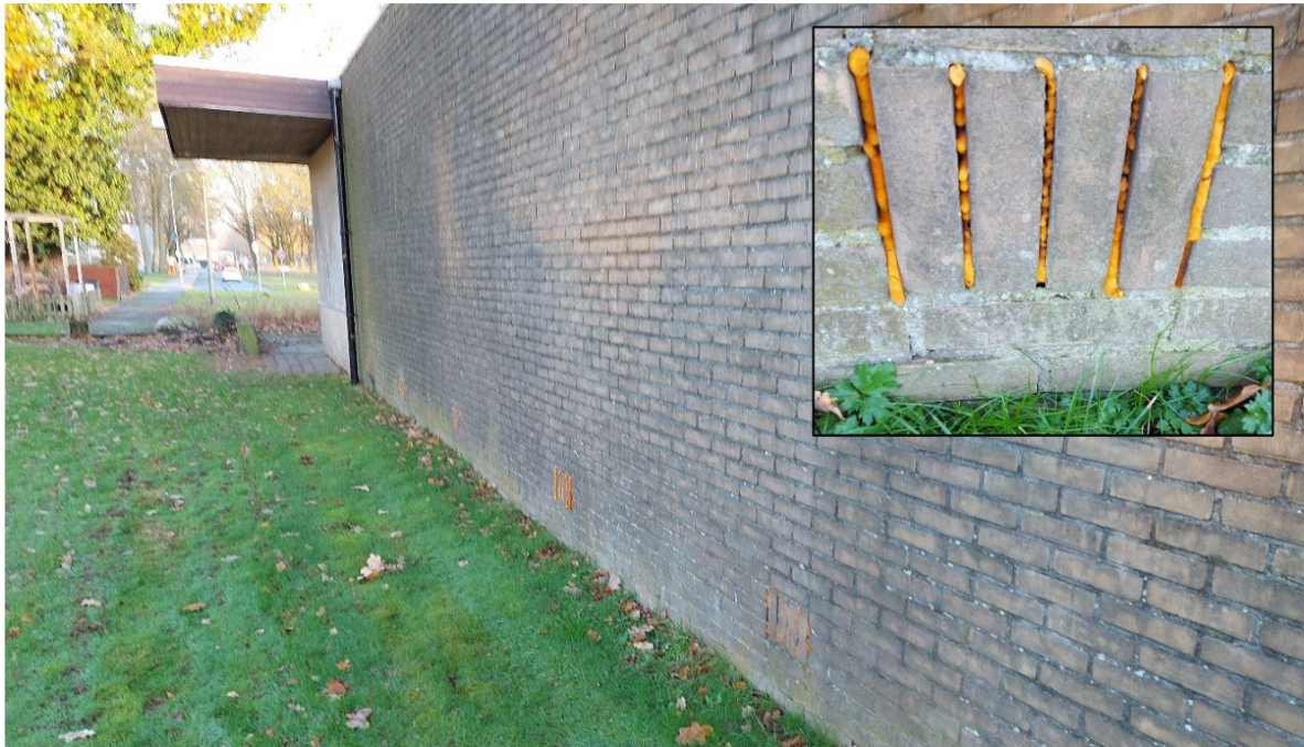
De ventilatiegaten rondom zijn gedicht met purschuim.
