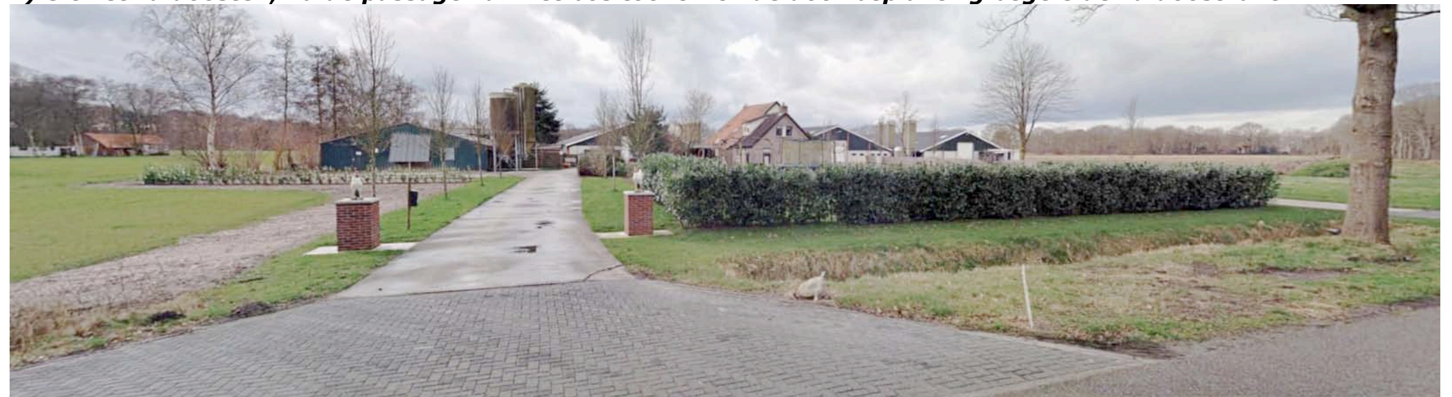
2) Ter hoogte van het plangebied wordt het beeld bepaald door kopgevels, woning en prunushaag.
