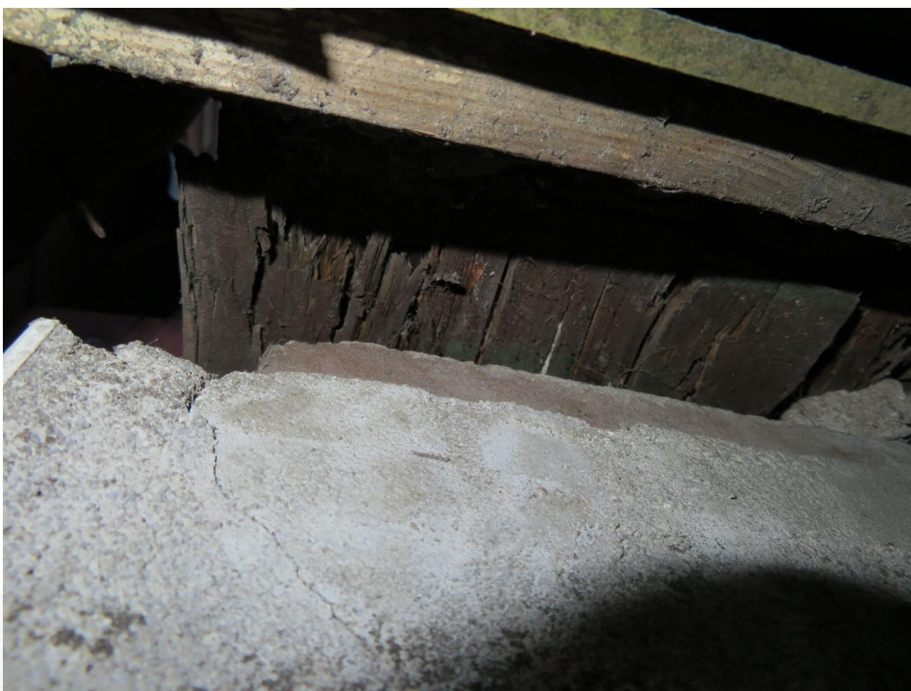
Afbeelding 3: Achter de opening is geen achterliggende ruimte: tussen dakbeschot en muur zit 1cm die vol ligt met puin.
