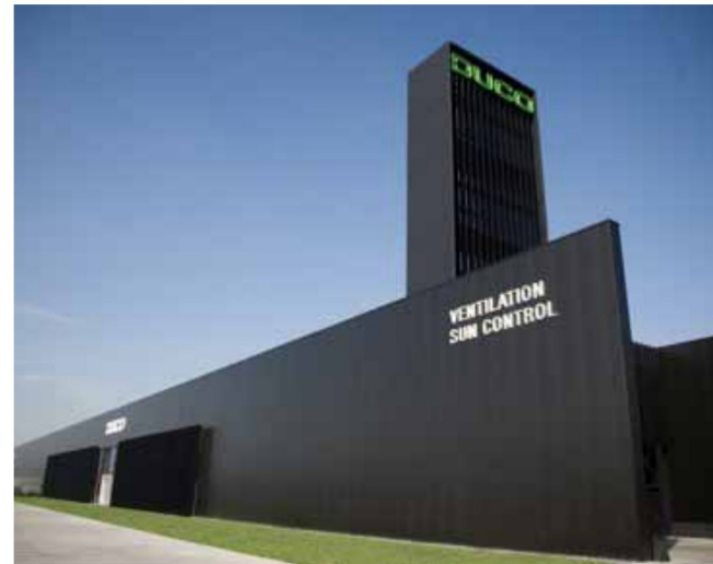
Installaties zichtbaar opgenomen in architectuur.
