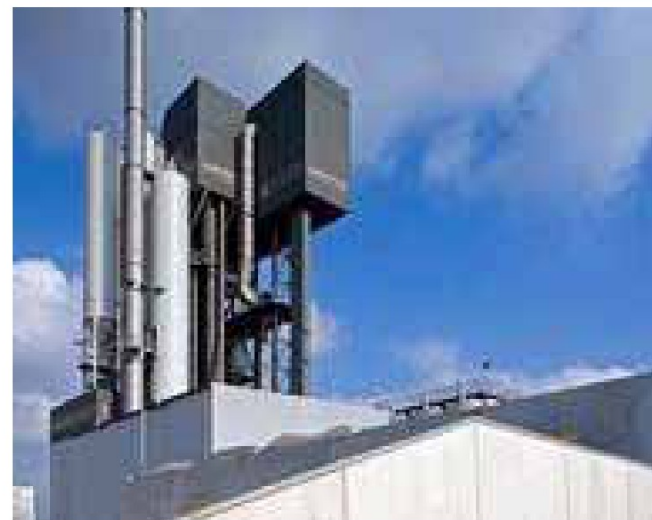
Rustige onderbouw, zichtbare installatie.
