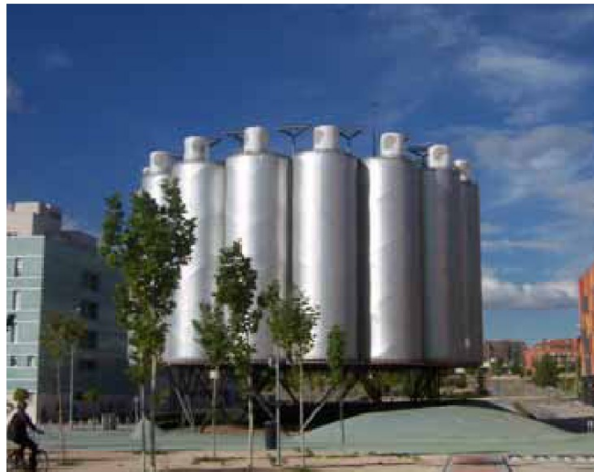
Bundeling van installaties.
