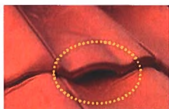
Figuur 5. Ventilatie dakpannen welke als invliegopeningen dienen voor de laatvlieger en gewone dwergvleermuis, en het dak toegankelijk maakt voor vleermuizen.
