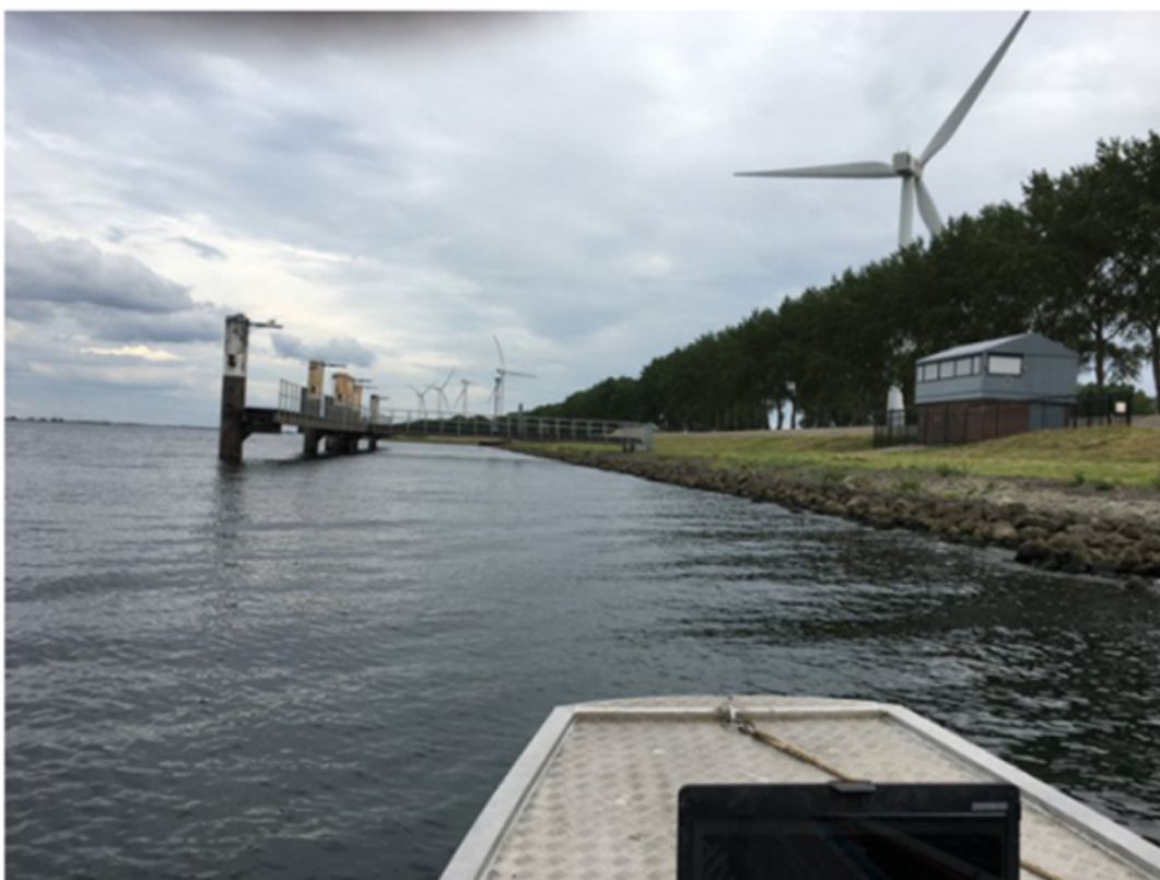
Figuur 2.4. De oever van het Haringvliet in het plangebied ter hoogte van dwarsprofiel DP-02. Op de oever is de steenbestorting te zien waarop de tijdelijke werkstrook wordt aangelegd.
