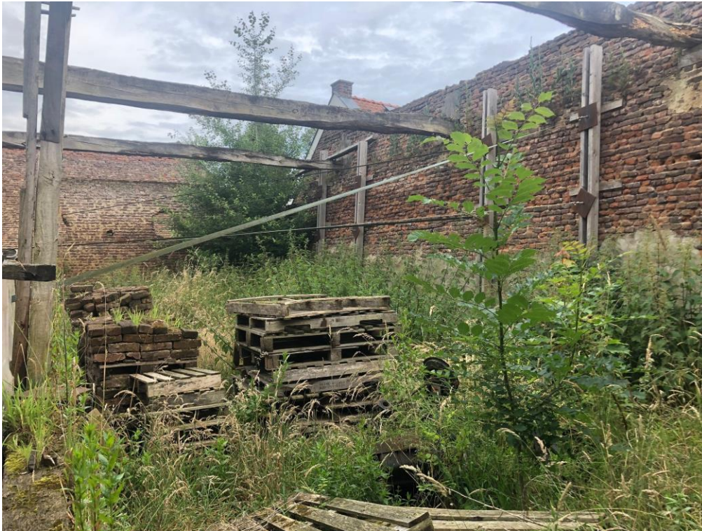
Figuur 1. Het nog te renoveren deel van het gebouw bevat geen spouwmuren of dak.
