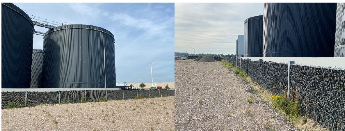
Afbeelding 4. De vergistingsinstallatie ten zuiden van de bouwkael (links) en de scheiding tussen de bestaande vergistingsinstallatie en de bouwkael (rechts).
