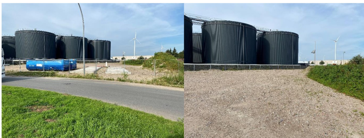
Afbeelding 3. Het bouwvlak gezien vanaf de Berlijnseweg (links) en op het terrein zelf (rechts).
