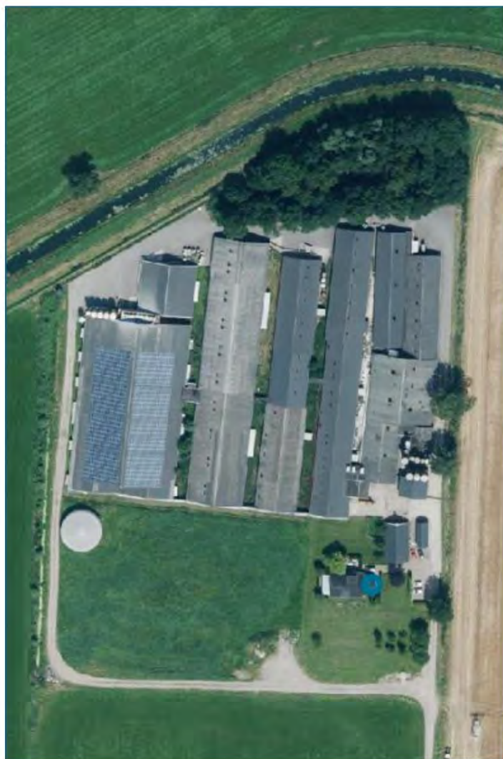
Figuur 3: luchtfoto van het bedrijf (Bron: pDok)
