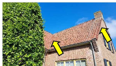
Figuur 5.4 Overhangende dakpannen en ruimte bij dakgoot woonhuis.
