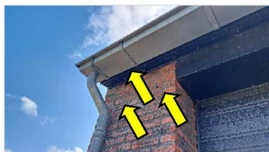
Figuur 5.3 Open stootvoegen en ruimte onder dakrand opslagloods.
