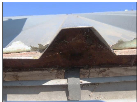
Fig. 2.3, Detailopname damwand met isolatie (bron: FF Solutions)
