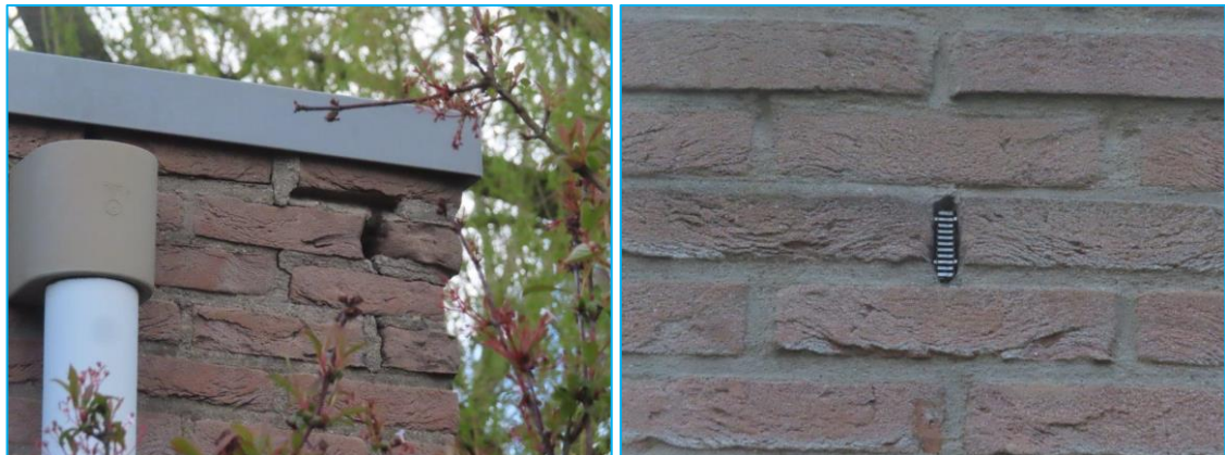
Foto's: Opening die in potentie toegang kan bieden naar een vleermuizenverblijf en rechts een stootvoeg met bijenbekje.
