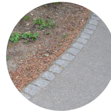
Parkpaden in asfalt met vaste afstrooilaag en rand van keitjes.
