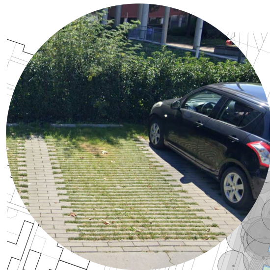
Parkeervakken in grasbetonsteen. Uitstapstroken in dichte steen voor comfort ivm de doelgroep
