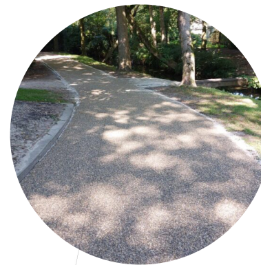
Parkpaden in asfalt met vaste afstrooilaag en rand van keitjes.
