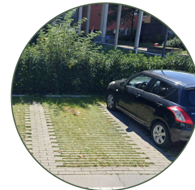
Open verharding met dichte uitstapstroken
