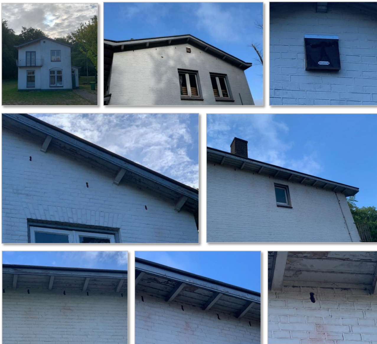
Foto's aangebrachte vleermuisverblijven (stootvoegen met toegang tot spouw en vleermuiskasten) in witte villa.
