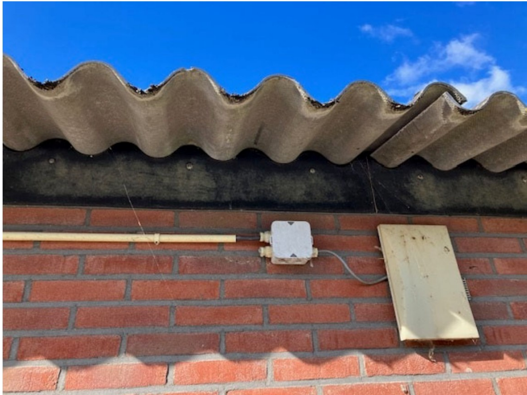
• Afbeelding 7: Onderzijde golfplaten, naadloos dicht gemaakt
