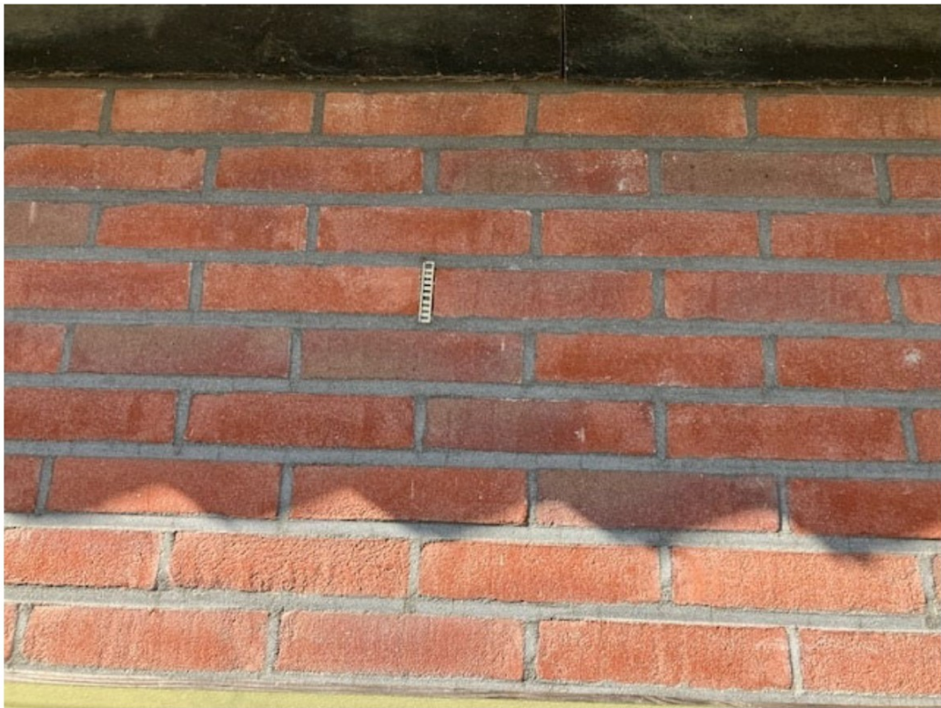
• Afbeelding 21: bijenbekjes in alle open stootvoegen
