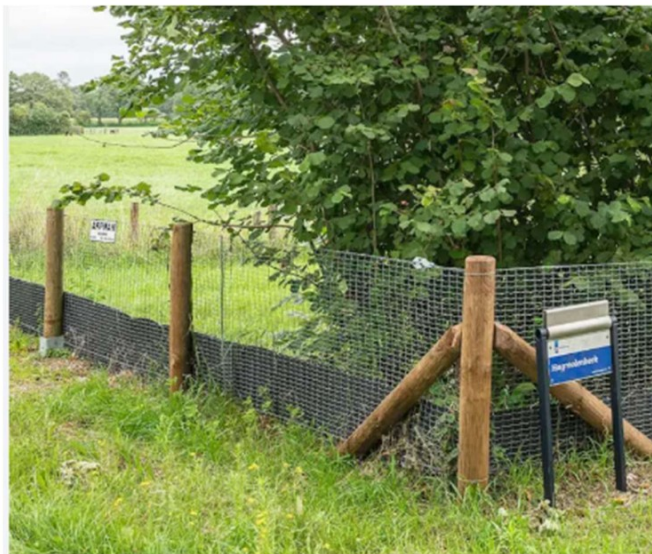
Figuur 2.2 Voorbeeld amfibieënscherm met wildraaster (bron: Arfman hekwerk)
