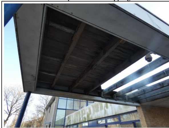
Foto 6 ontbrekend plafond overkapping
