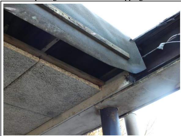
Foto 7 opening in dakruimte overkapping
