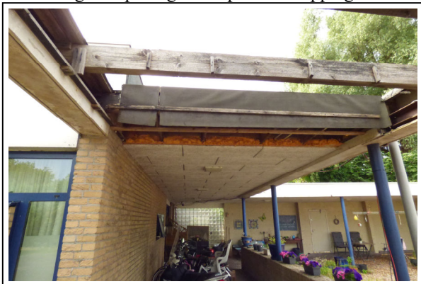
Foto 11 geen openingen in open overkapping
