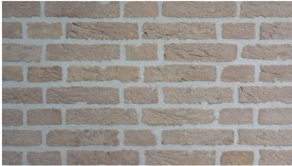
De twee gebruikte materialen in de gevels: geelkleurig hardgrauw in Noors verband en grijsgekleurd sierpleisterwerk met split.
