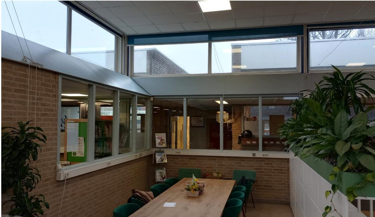
De later gerealiseerde docentenkamer / bibliotheek (links) steekt iets door in de aula. De overgang is middels een schuin geplaatste, houten plaat gemaakt.
