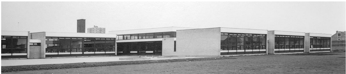
Foto's van de Paus Joannesschool vlak na oplevering in 1968. Boven vanuit het noorden (hoek De Weer-Middelven), onder vanuit het noordwesten (Middelven). De foto's laten duidelijk het verschil zien tussen de gevels van de gangen (opeenvolging van gesloten en transparante delen) en die van de klaslokalen (vrijwel geheel transparant). Op de foto onder is centraal de aan de aula grenzende veranda zichtbaar (Archief Paus Joannesschool).
