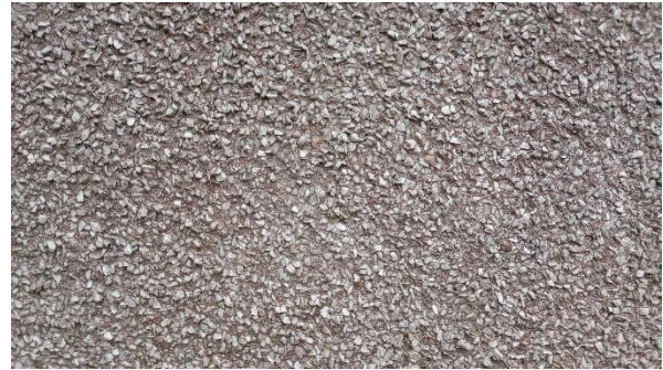
De twee gebruikte materialen in de gevels: geelkleurig hardgrauw in Noors verband en grijsgekleurd sierpleisterwerk met split.
