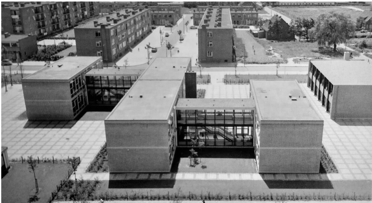
H-school in Rotterdam-Zuidwijk (1961). Verticale stijpunten zijn opgenomen in de gangzones die de lokalenblokken met elkaar verbinden. Een aula ontbreekt (Verstegen 2008).
