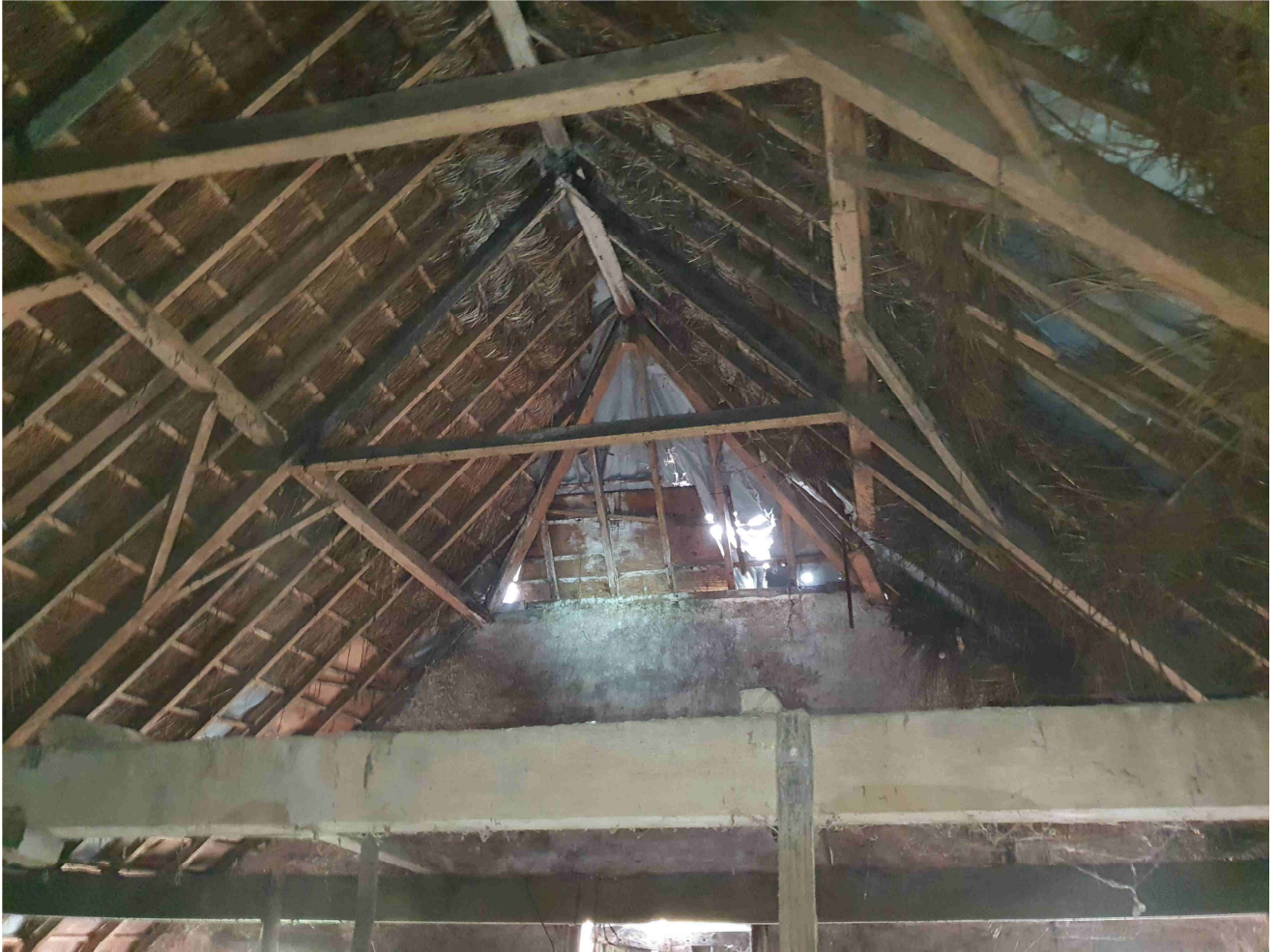
Aanzicht dak achtergevel
