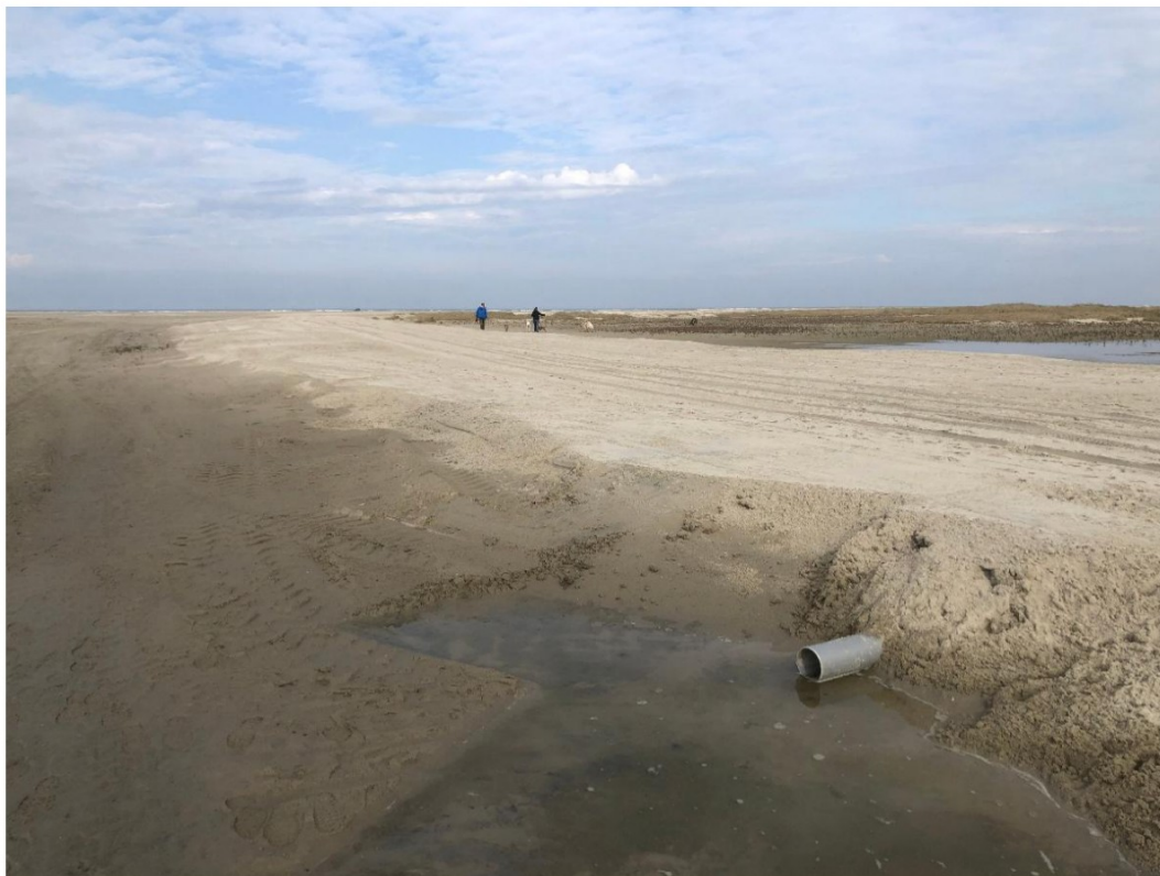
Figuur A3. Pas aangelegd pad in maart 2025. De buis was na 2 dagen verstopt met zand. Foto 23-3-2025.
