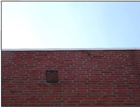
Fig. 2.6, Open stootvoegen (bron: FF Solutions)
