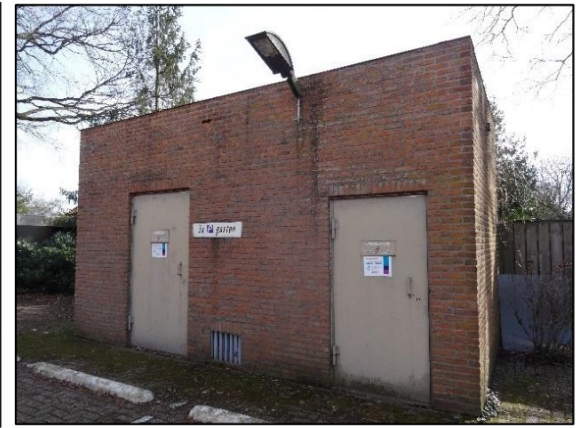
Fig. 2.9, Bijgebouw, geen open stootvoegen (bron: FF Solutions)
