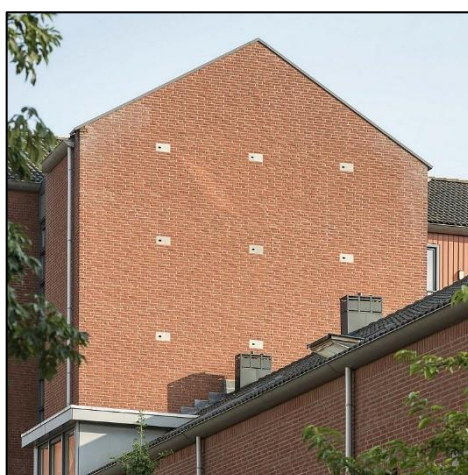
Afb 14 + 15: Gierzwaluwkasten ingemetseld (worden ook gebruikt door Huismussen)
